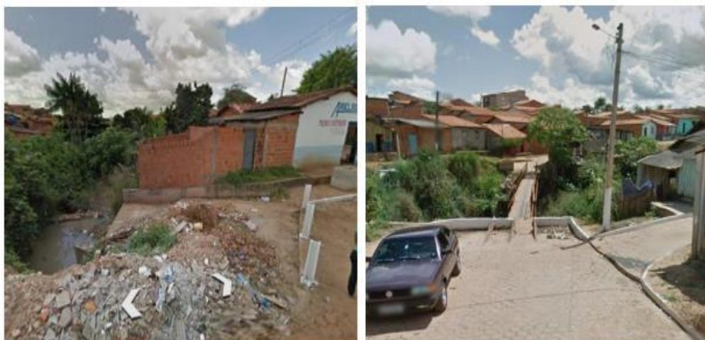
Figura 1 - Início da erosão na rua Maranhão encontro com a rua São Francisco de Açailândia - MA.
