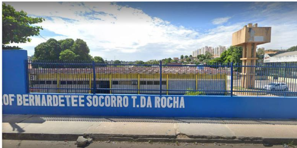
Figura 1 – Fachada da Escola Estadual Prof Bernadete do Socorro Trindade da Rocha no ano de 2021.
