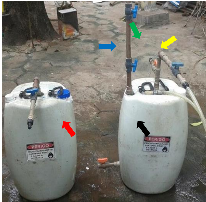
Figura 3- Biodigestor e bomba de armazenagem.
