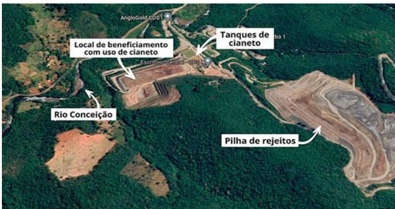
Figura 2 – Vista da área das instalações do Córrego do Sítio I.
