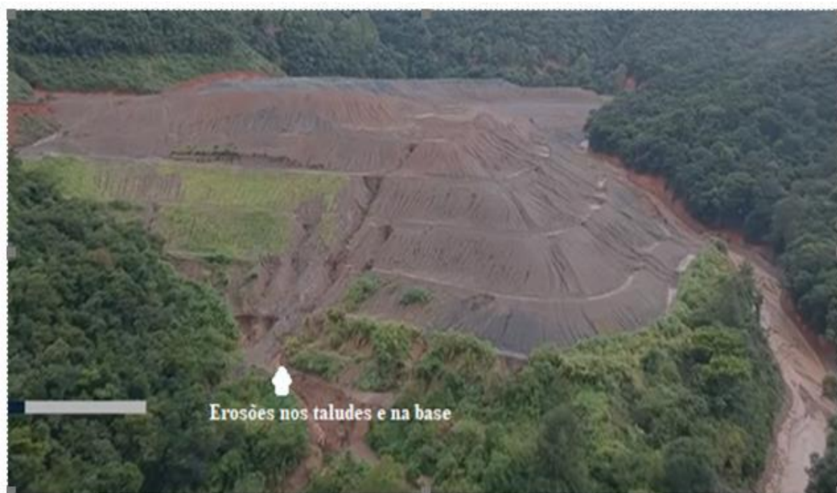
Figura 1 – Vista área dos taludes.
