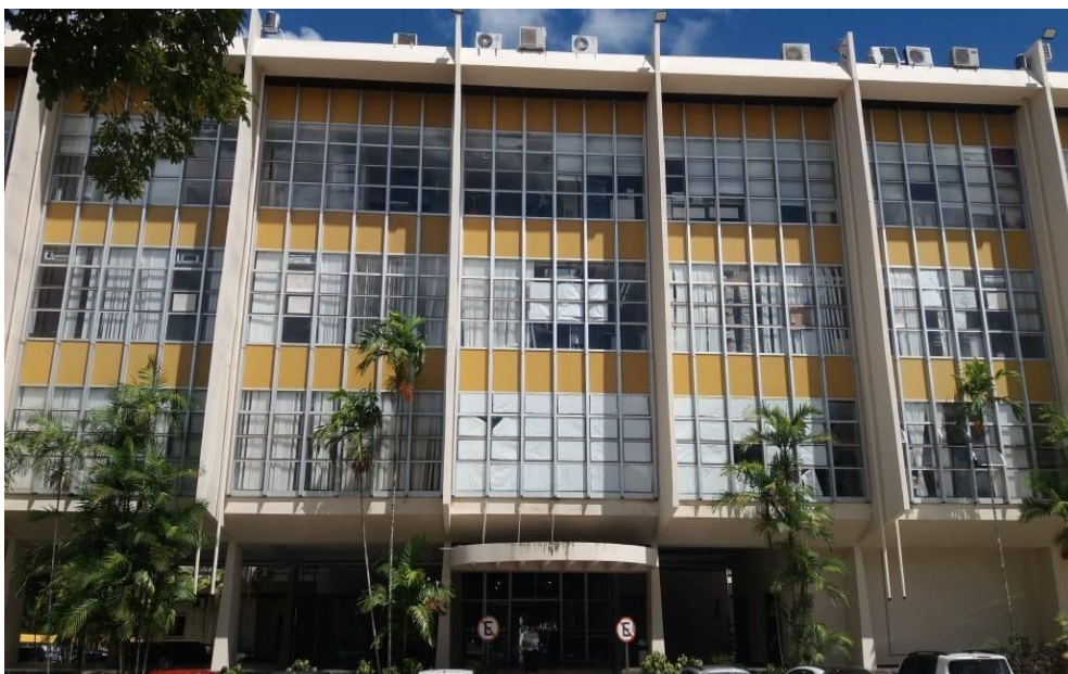
Figura 2 - Prédio da Reitoria onde se localiza a PROGEP.
