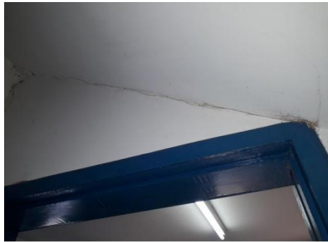
Figura 10: Escada descarregando sobrecarga em alvenaria.
