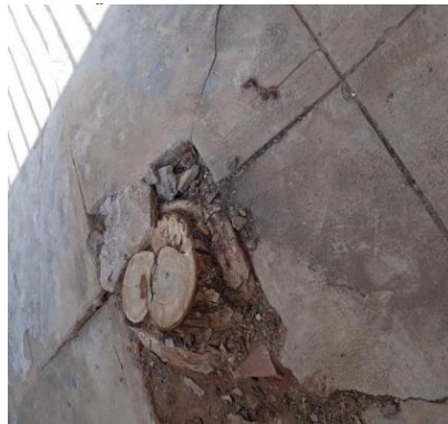
Figura 15: Piso do estacionamento da escola.
