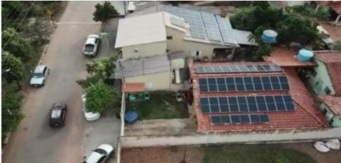
Figura 14 – Sistemas solar FV de 24,9 KWp.
