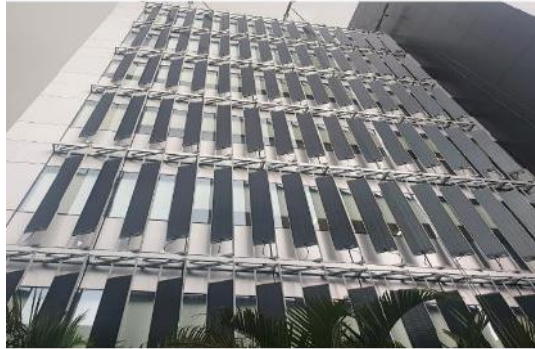
Figura 6 - Sistema on grid com tecnologia BPIV (fachada de prédio solar).
