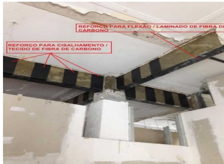
Figura 3 - Reforço de fibra de carbono em vigas de concreto armado.
