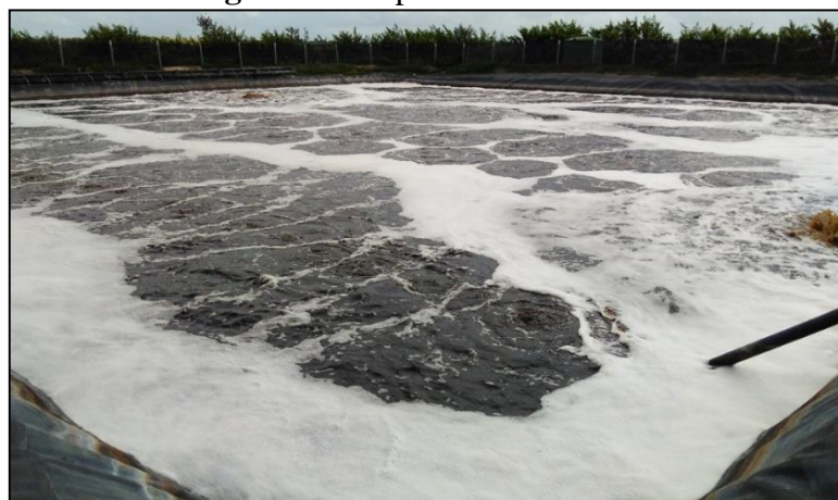
Figura 4 - Etapa aeróbia da ETE.
