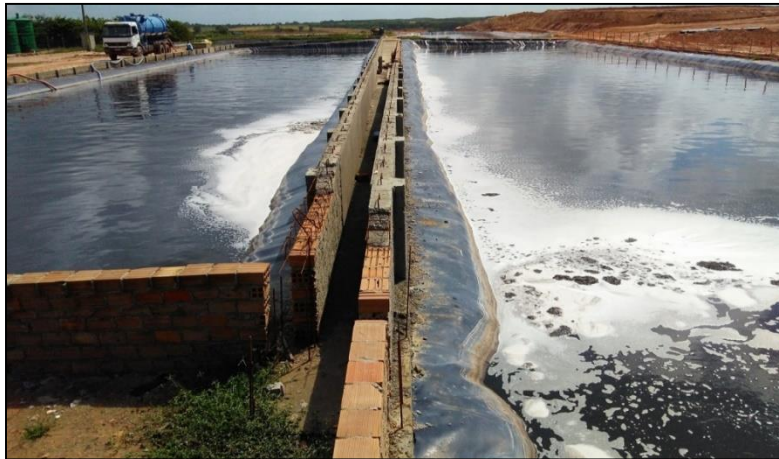
Figura 3 - Lagoa Anaeróbia da ETE do Aterro Sanitário de Maceió.
