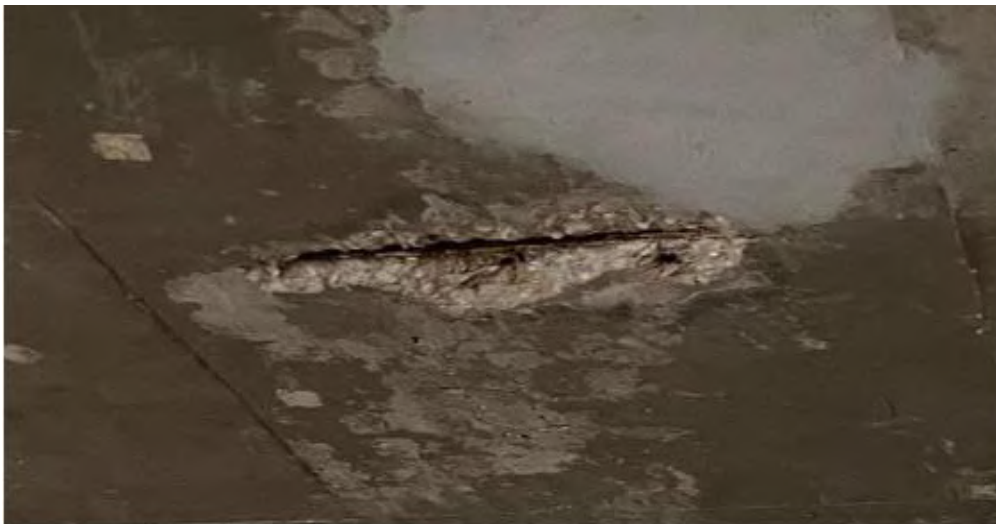
Figura 1 – Exposição de armaduras.
