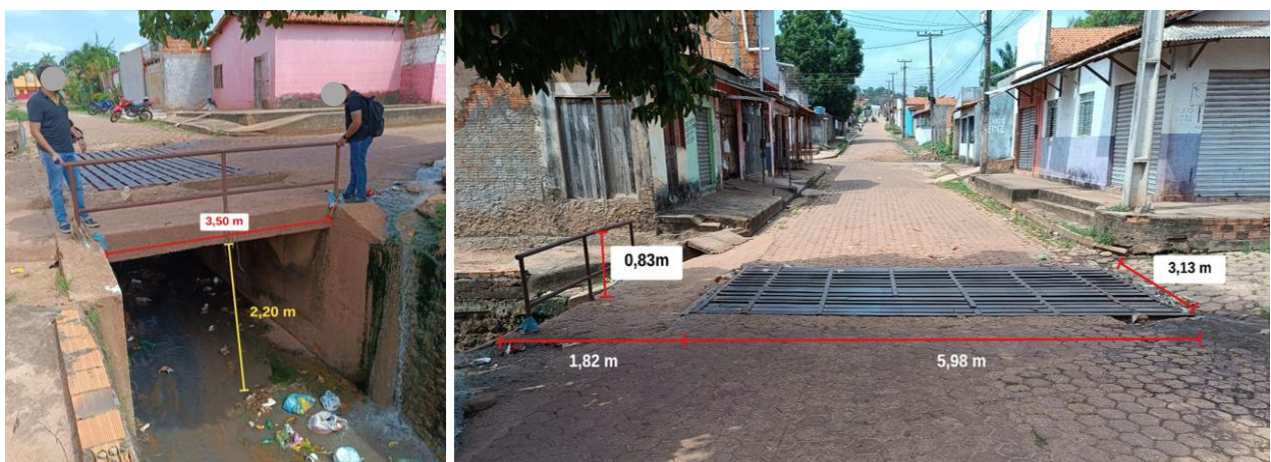
Figura 1 – Dimensões do primeiro pontilhão metálico analisado no bairro Vila Ildemar, Açailândia-MA.
