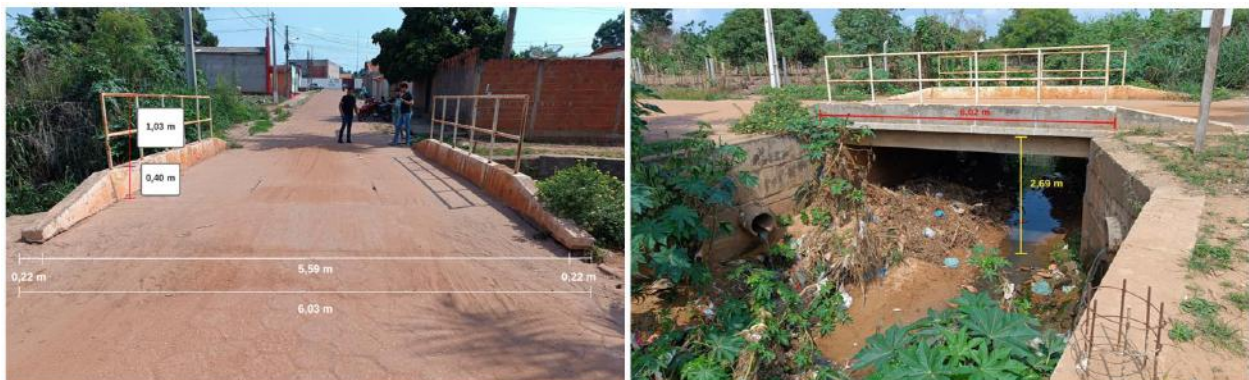
Figura 8 – Dimensões do segundo pontilhão de concreto armado.
