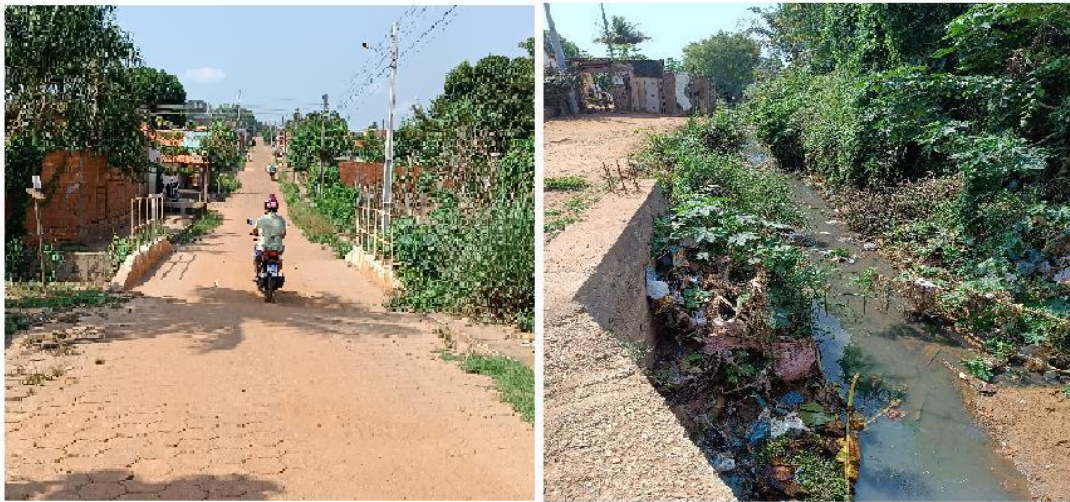
Figura 7 – Pontilhão em uso e a presença de residência na beira do córrego.
