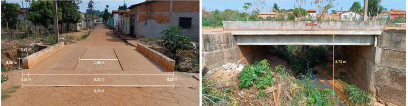
Figura 5 - Pontilhão em concreto armado.
