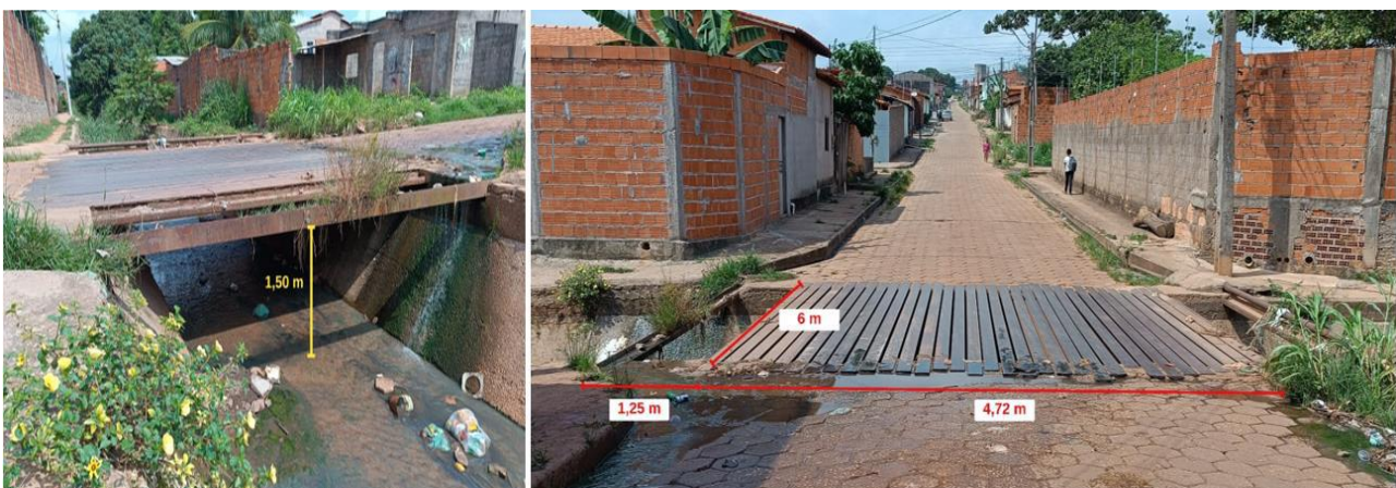
Figura 3 – Dimensões do segundo pontilhão metálico analisado no bairro Vila Ildemar, Açailândia-MA.
