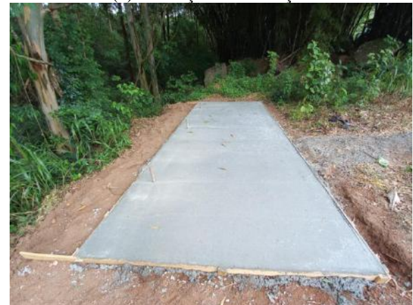
(d) Leiras concretadas
