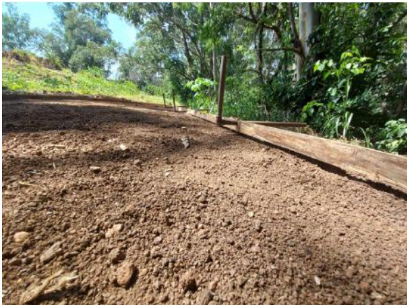
(a) Preparo do terreno
