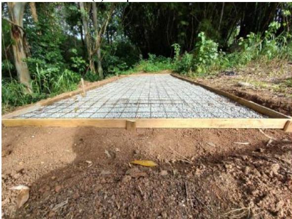
(c) Preparo das leiras para receber o concreto usinado
