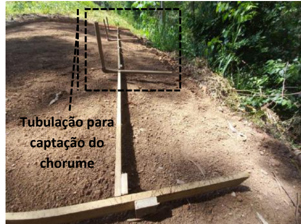
(b) Instalação da tubulação
