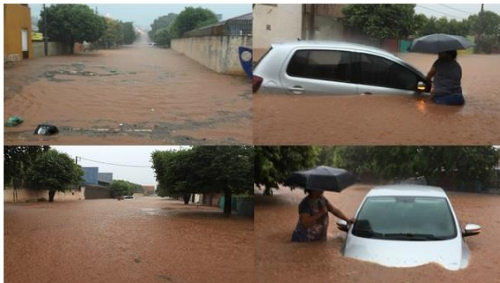
Figura 2: Alagamento no bairro Jardim Alvorada em 2015.
