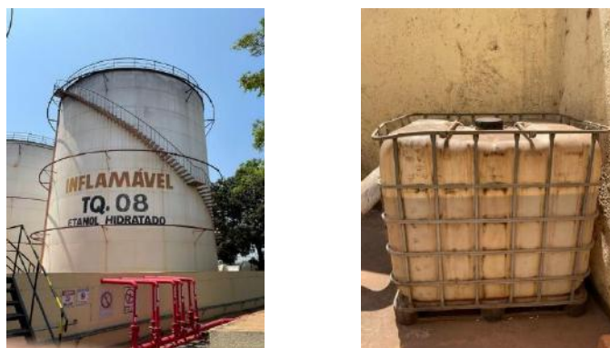
Figura 1 - (a) Tanque estacionário de armazenamento de etanol hidratado construído em aço carbono A36; (b) Tanque reservatório de 1000 litros com etanol hidratado proveniente da higienização do tanque estacionário.
