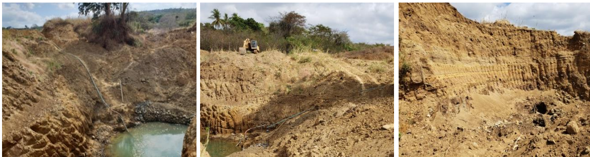
Figuras 8, 9 e 10 - Decapeamento, escavação
