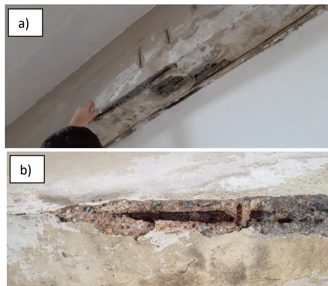
Figura 13: Ensaio de carbonatação na viga.
