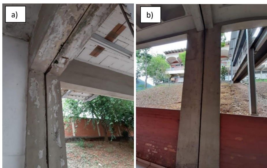
a) Junta de dilatação no bloco 1; b) Junta de dilatação no bloco 2
