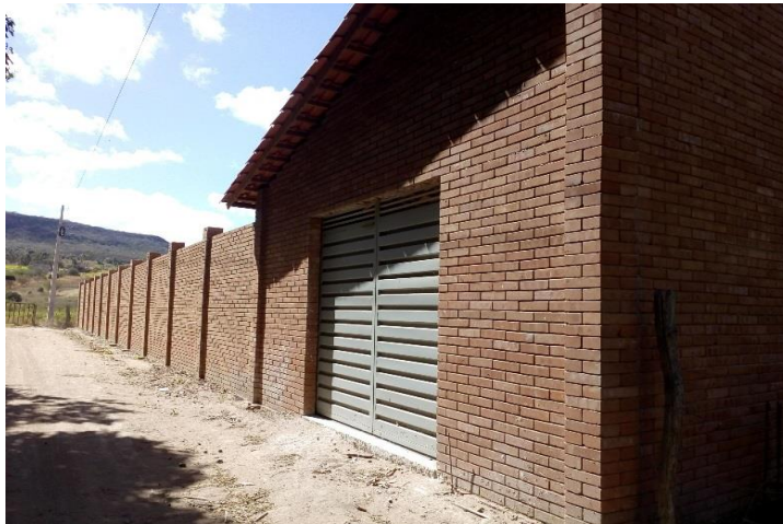
Figura 9: Galpão da fábrica construído com tijolos de solo-cimento.
