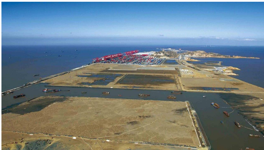
Figura 8: Construção da ilha, ou plataforma, artificial de Yangshan.
