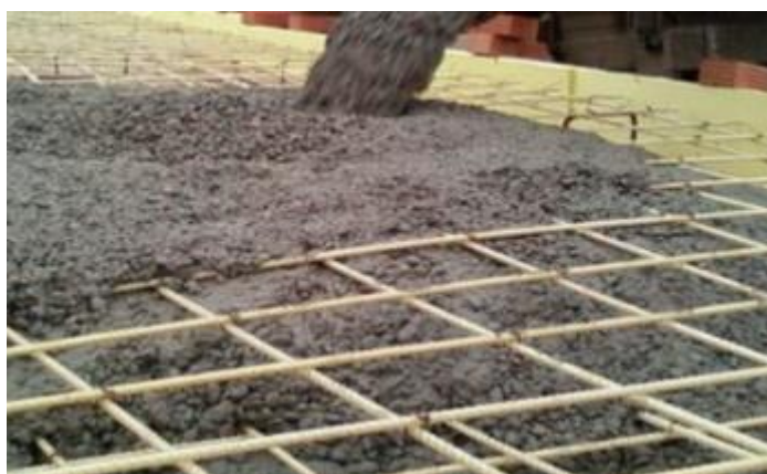
Figura 1: Elaboração de uma viga, tendo a estrutura metálica envolvida por concreto.
