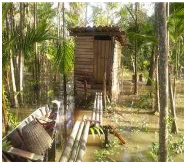
b) Sanitário local - Efeito da maré.
