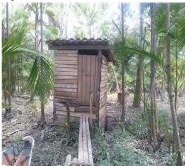
Figura 2. a) Sanitário local.
