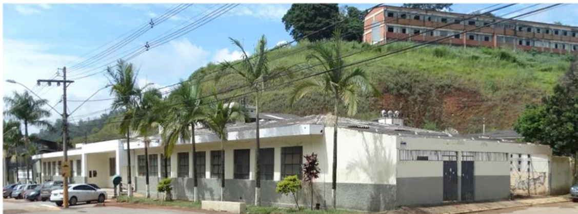
Figura 2 - Vista da UEMG e do presídio de João Monlevade.
