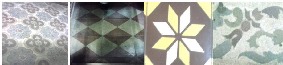
Figura 2. Imagem dos ladrilhos hidráulicos e artes da Igreja.
