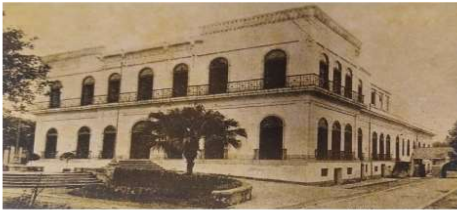
Figura1 - Fachada da Escola Normal de Artes e Ofícios Wenceslau Braz - 1917
