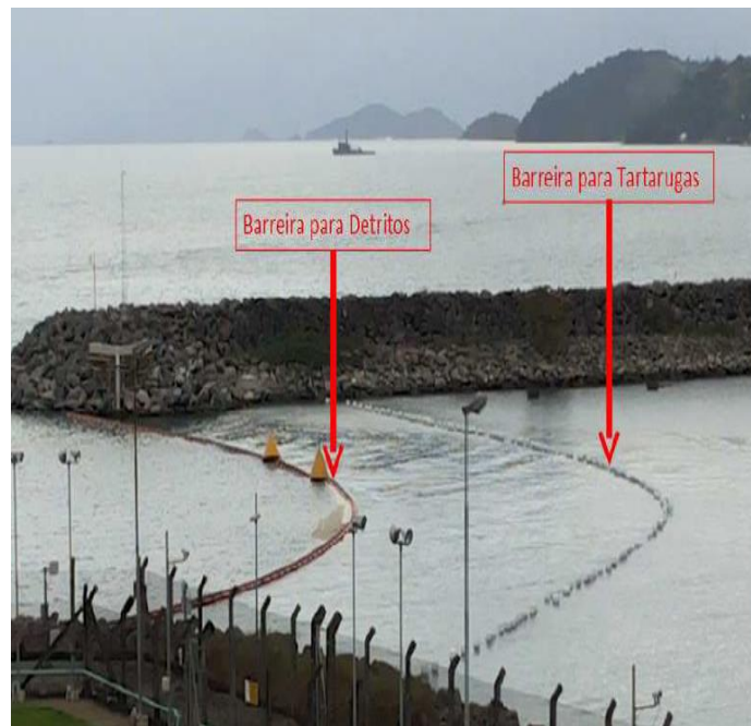
Figura 9. Barreira para Detritos, Barreira para Tartarugas, para proteção da usina de Angra.
