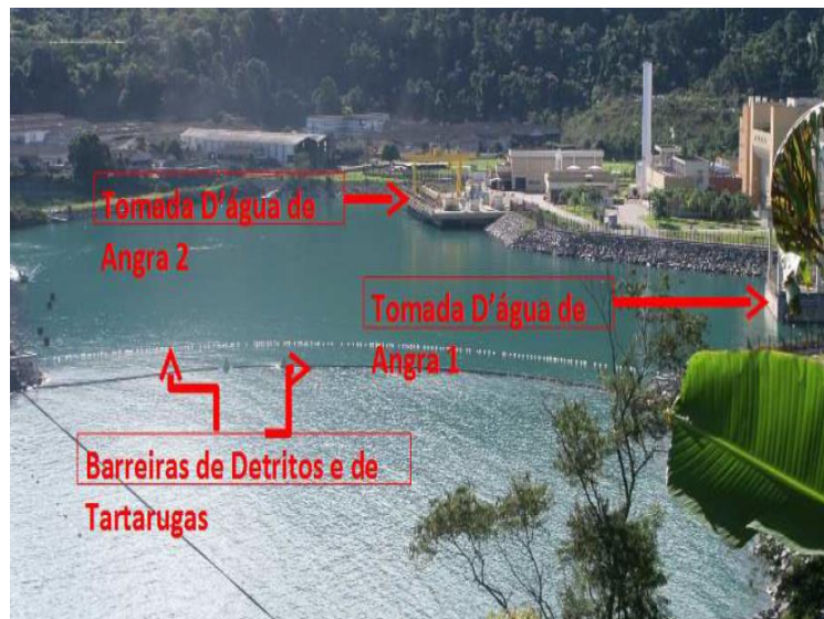
Figura 8. Esquema de projeto de Barreiras de detritos e de tartarugas, tomada d'agua de Angra I, tomada d'agua de Angra II.
