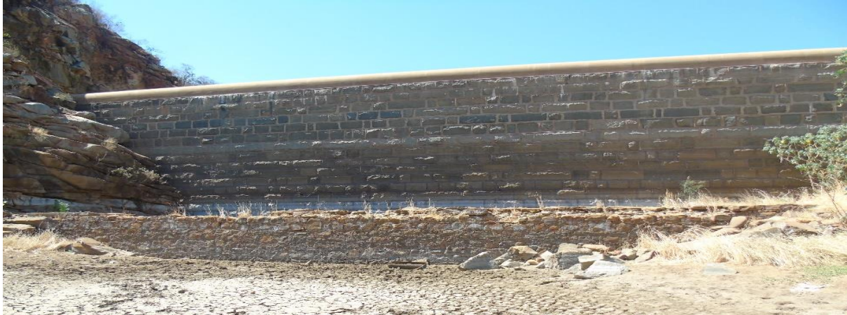
Figura 5. Vista da parede principal a montante da barragem do Saco I.
