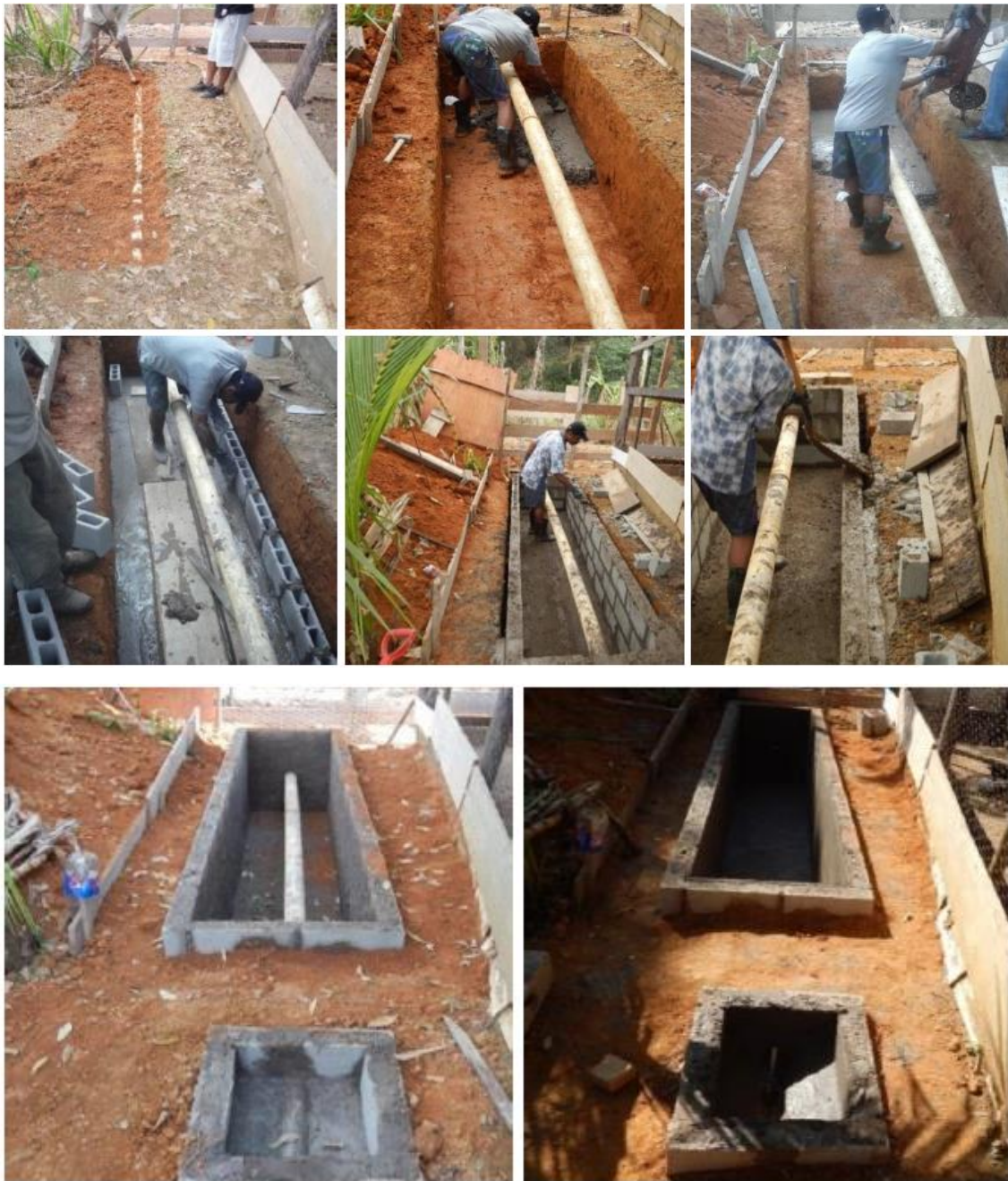
Figura 2. Registro fotográfico da construção do Sistema Alagado Construído.
