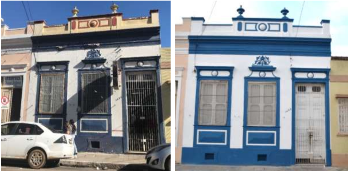
Figure 14: Preliminary survey of the facade - Block 1.3 Street Voluntários da Pátria, 1405 versus final survey of the facade - Block 1.3 Street Voluntários da Pátria, 1405.
