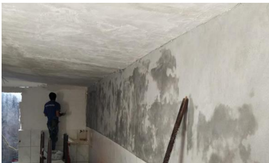
Figura 13 - Aplicação da camada de gesso sobre o EPS.
