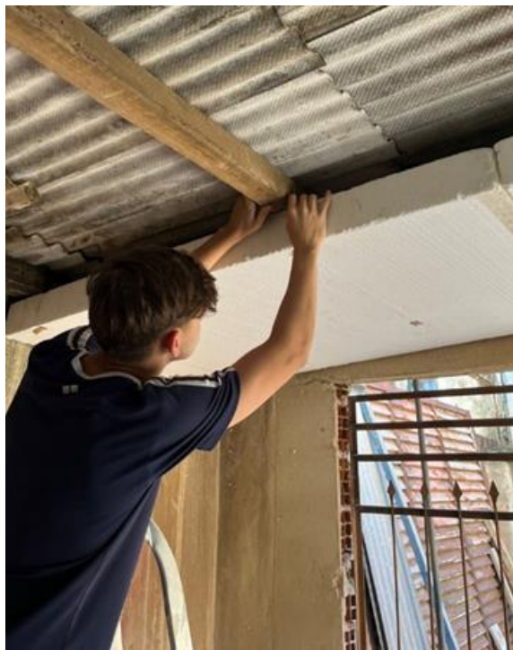
Figura 12 - Instalação das placas de EPS com o suporte metálico.
