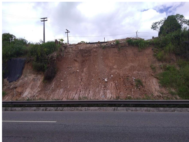
Figura 10 – Talude após demolição de residências em 2019.
