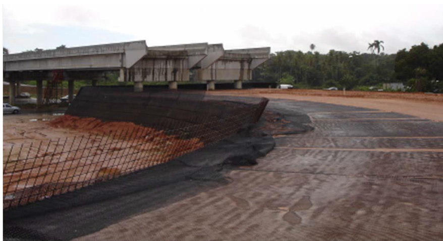
Figura 2 - Aterro construído em solo reforçado em João Pessoa.
