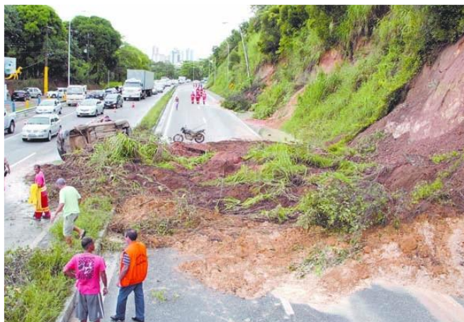
Figura 8 - Deslizamento no talude da BR 230 na comunidade Santa Clara em 2012.
