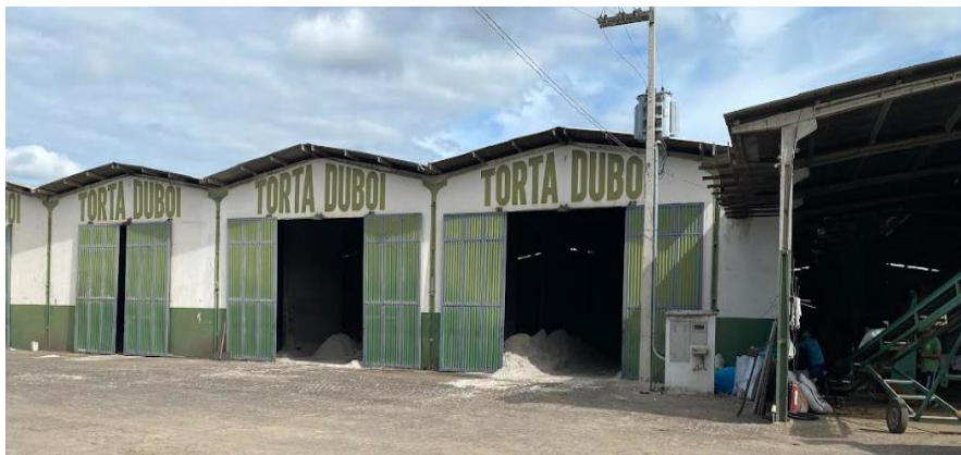
Figura 5 - A empresa de torta Duboi de Sousa - PB possui 6 armazéns de estocagem de caroços de algodão. Cada armazém pode receber 35 carretas de caroços de algodão com 50 toneladas, sendo o total de 1.750 toneladas. No geral para os 6 armazéns, a capacidade de estocagem é de 10.500 toneladas.
