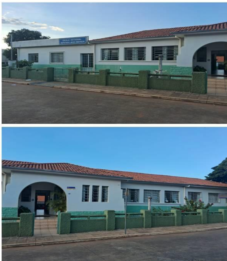
Figura 2 - Vista externa da Escola Estadual Deputado Jales Machado, localizada no município de Alterosa (MG).
