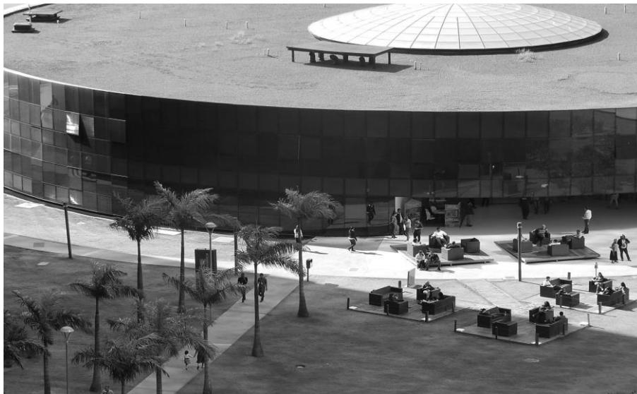
Figura 1: Fotografia 1 do complexo arquitetônico cidade administrativa
